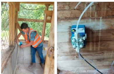
Ilustración 22: Instalación de clorinador en pozo Mutiwás 2025
